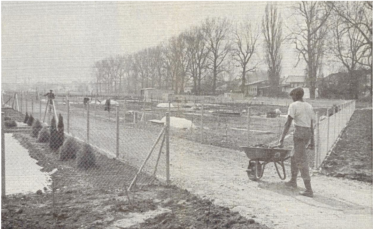
Elfrin wird derzeit in der Wamm gewerkelt: Die ersten 21 Parzellen der Kleingartenanlage sind bereits vergeben.
